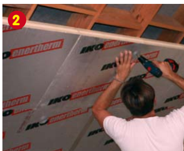
2 Vissez la plaque enertherm Comfort Alu TG avec au moins 2 vis + rondelle.
