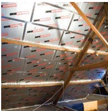
2 Vissez la plaque enertherm Comfort Alu TG avec au moins 2 vis + rondelle.
