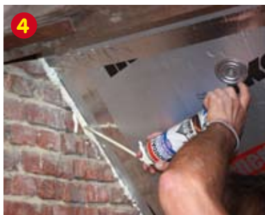
4 Appliquez de la mousse PU dans les jointures entre la bois/brique et les plaques enertherm Comfort Alu TG.
