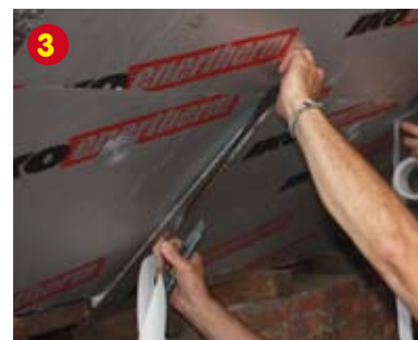
3 Collez à présent une bande adhésif Alu-Tape sur toutes les jointures séparant les plaques enertherm Comfort Alu TG.
