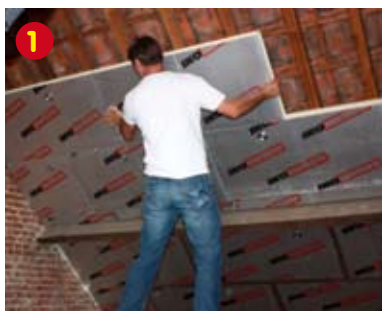
1 Posez la première rangée d' enertherm Comfort Alu TG horizontalement de manière à garantir le bon assemblage.
